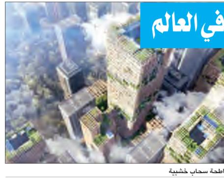
في شرفات في كل طابق بحسب ما ذكرت الـ «BBC»... وقالت الشركة إن دعوات من الفولاذ الملقى على شكل أنبوب، لمواجهة الاهتزازات، ستكون في وسط مبنى البرج، بهدف حمايته من الزلازل التي تشهدها طوكيو بشكل متكرر، وتبلغ التكلفة المتوقعة للبرج نحو 5.6 مليار دولار، وهي ضعف تكلفة برج تقليدي من ناطحة سحاب خشبية في العالم. صديق للبيئة تترك المباني الأسمنتية والفولاذية آثارا كربونية في البيئة.
