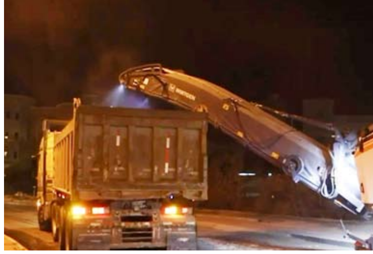
رفع الاسفلت تمهيدا لصيانة الطريق
