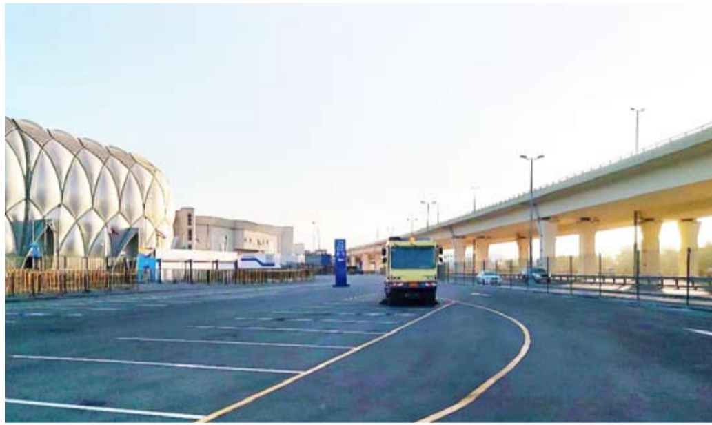
جانب من أعمال صيانة الطرق
